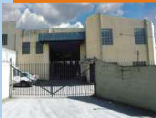
Unidade de Manutenção Válvulas e Atuadores - Cajamar/SP
